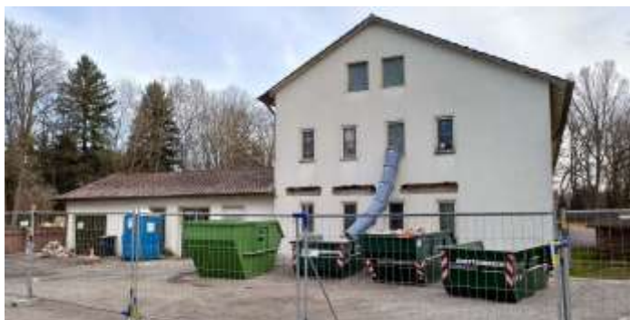
Die Bauarbeiten an der alten Schule haben begonnen.
