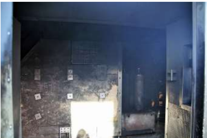
So schaut es im Inneren der Brandsimulationsanlage aus. Bei der Übung muss einem Treppenbrand eine brennende Gasflasche (rechts) gelöscht werden.
